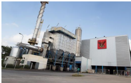
โรงไฟฟ้าพลังงานขยะ หาดใหญ่
