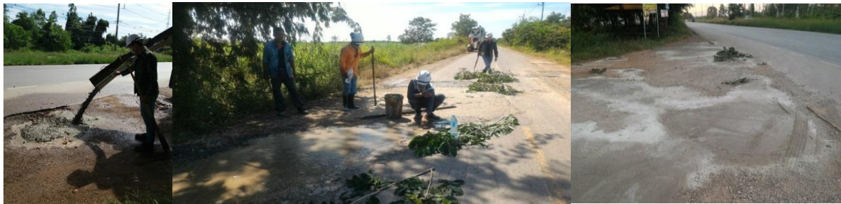
รูปภาพปรับปรุงถนนดำเนินการแก้ไขถนนทางเข้าหมู่บ้าน โดยเทศบาลนครบริเวณที่เป็นหลุมเป็นบ่อ ดำเนินการแล้วเสร็จ 80%
