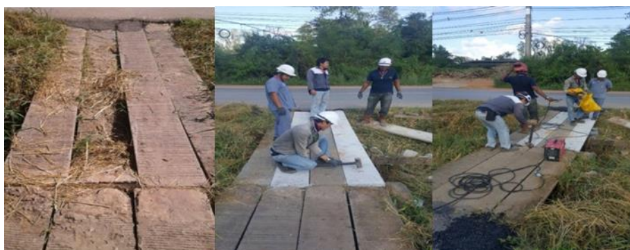
รูปภาพซ่อมแซมทางข้ามถนนสำหรับรถจักรยานยนต์ ดำเนินการปรับปรุงแซมทางข้ามถนนสำหรับรถจักรยานยนต์ เรียบร้อยแล้ว 100%
