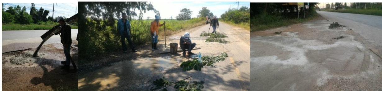
รูปภาพปรับปรุงถนน ดำเนินการแก้ไขถนนทางเข้าหมู่บ้าน โดยเทศบาลนครบรีเวณที่เป็นหลุมเป็นบ่อ ดำเนินการแล้วเสร็จ 80%
