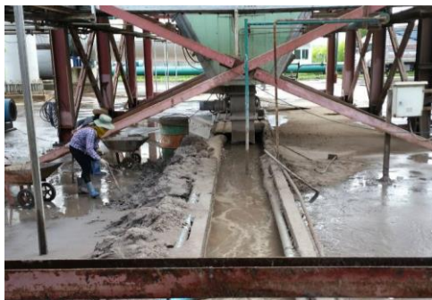
ภาพก่อนปรับปรุง
